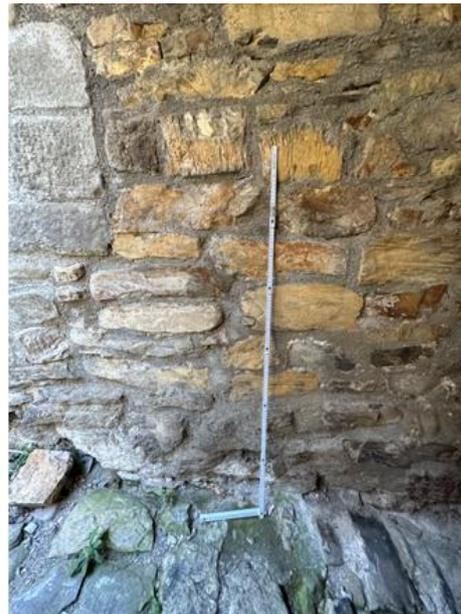
Si ottengono così due profili di IQM (MIN e MAX), ognuno dei due con valori minimi-massimi-medi dei parametri meccanici.
